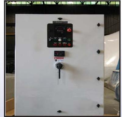
Hay disponibles arrancadores de estado sólido para todas las medidas de motores de transmisión en cualquier voltaje o característica de corriente.
